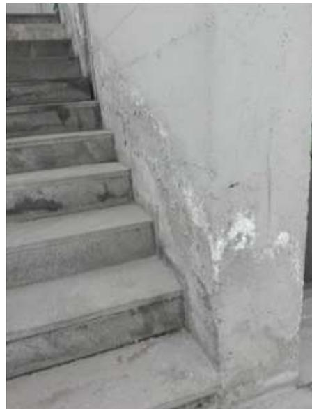
*Figura 5-10 Distacco calcestruzzo e scostamento lastre gradini*
