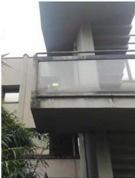
*Figura 5-9 Ammaloramento pianerottoli e parapetti in vetro*
