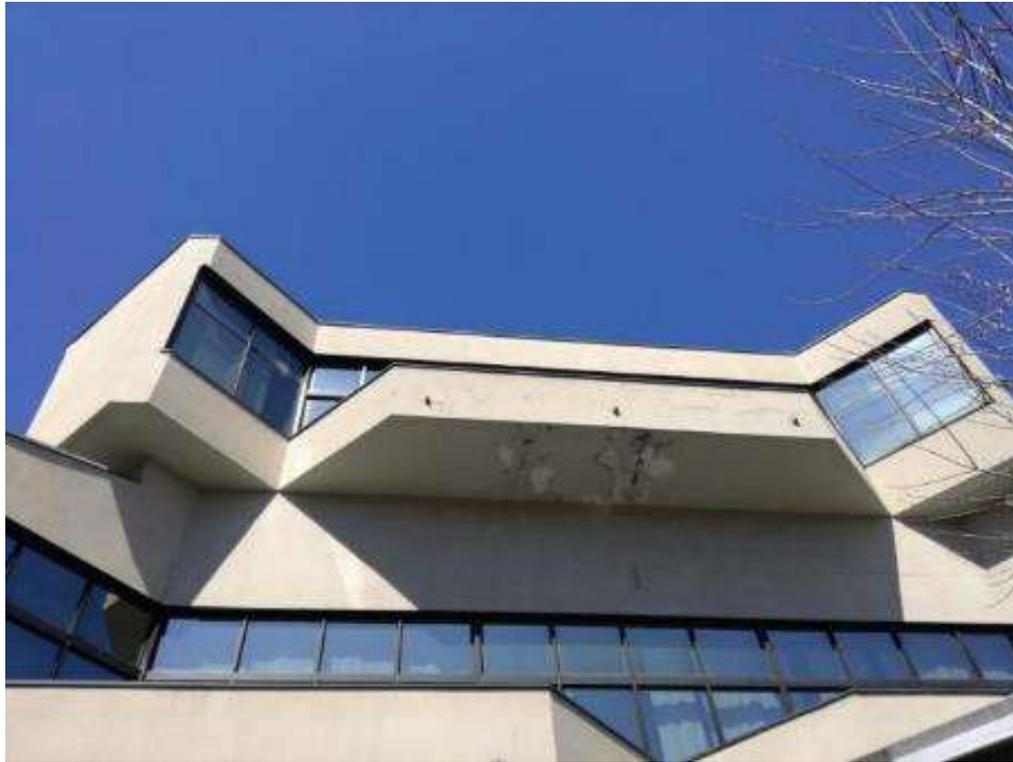
*Figura 5-5 Azione corrosiva dell'acqua sull'intradosso di un terrazzo della GAM*
