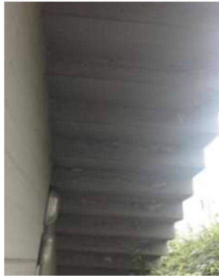
*Figura 5-8 Sfogliamento della vernice di protezione del calcestruzzo*
