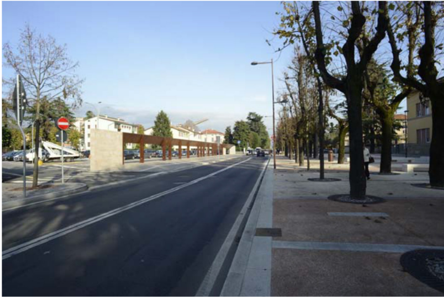
Scorcio di Viale Mazzini a seguito dell'esecuzione dei lavori
