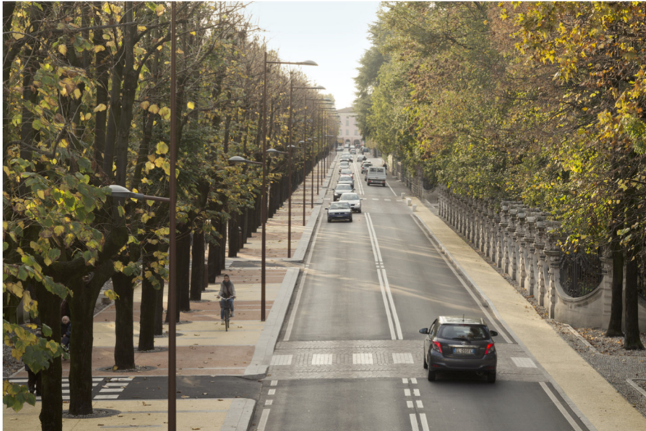
Viale Mazzini a seguito dell'esecuzione dei lavori
